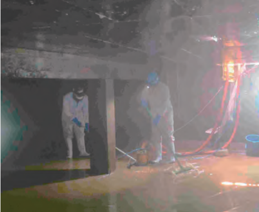
▲小深堀受水槽清掃作業 ＜ 各水道施設も計画的に清掃を行います＞
