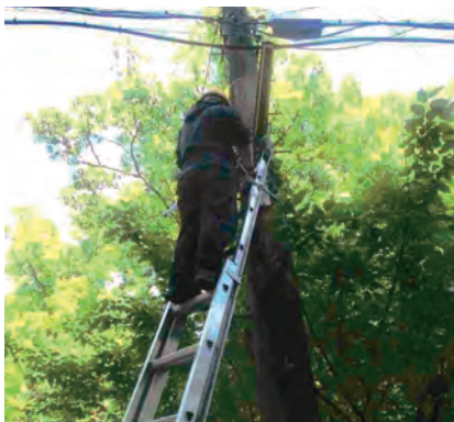
▲蛍光灯管の交換
