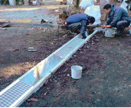
▲りんどう湖村側溝修繕 ＜劣化破損し、通行に支障があった側溝を新規に交換しました＞
