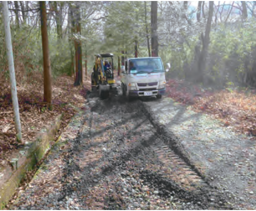
▲白沢橋砂利道の整備 ＜大雨により砂利が流れた砂利道の修復をおこないました＞
