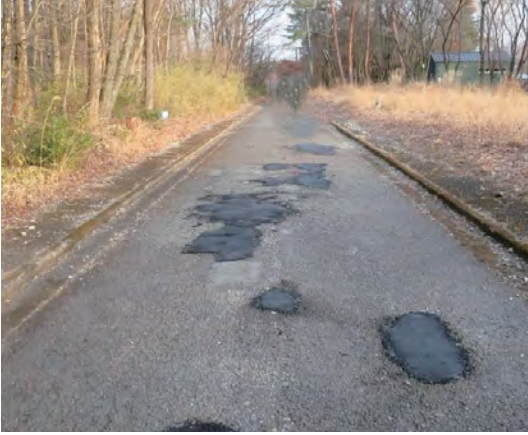
▲青木道路凸凹修繕 ＜部分修繕で凸凹を改修しました＞
