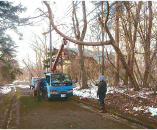
▲玉鳳台危険倒木の撤去作業 ＜土地所有者の許可の基で危険樹木の撤去を行いました＞
