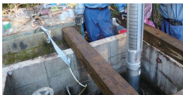
おおとり苑のポンプ交換工事：
