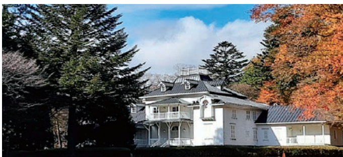
<写真③ 明治時代に、ドイツ公使や外務大臣等を務めた青木周蔵が那須別邸として建てた建造物です。平成11年12月に国重要文化財に指定されました。>
