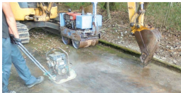
新野鳥苑 道路補修工事：
