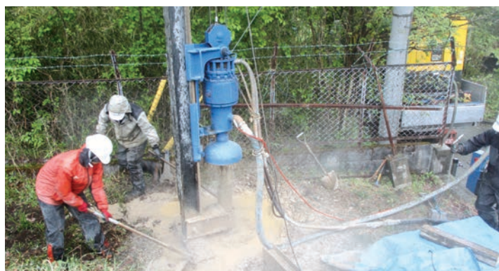
①五峰苑追加井戸試掘工事： 水源枯渇予防を兼ねて井戸試掘を行い、正式な井戸として水量・水質の安全性を確認の上で水道施設に登録しました。
