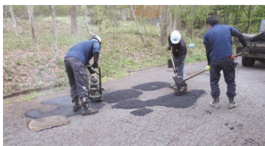
⑦新おとり苑道路補修： 道路の全面補修には多額の費用が掛かるため傷んだ箇所の補修を行います。
