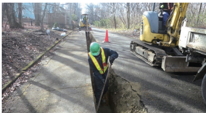
②町営水道引込工事： 様々な水質悪化対策案を検討しましたが、利用する会員の総意により、自治会初の町営水道引込工事をおこないました。
