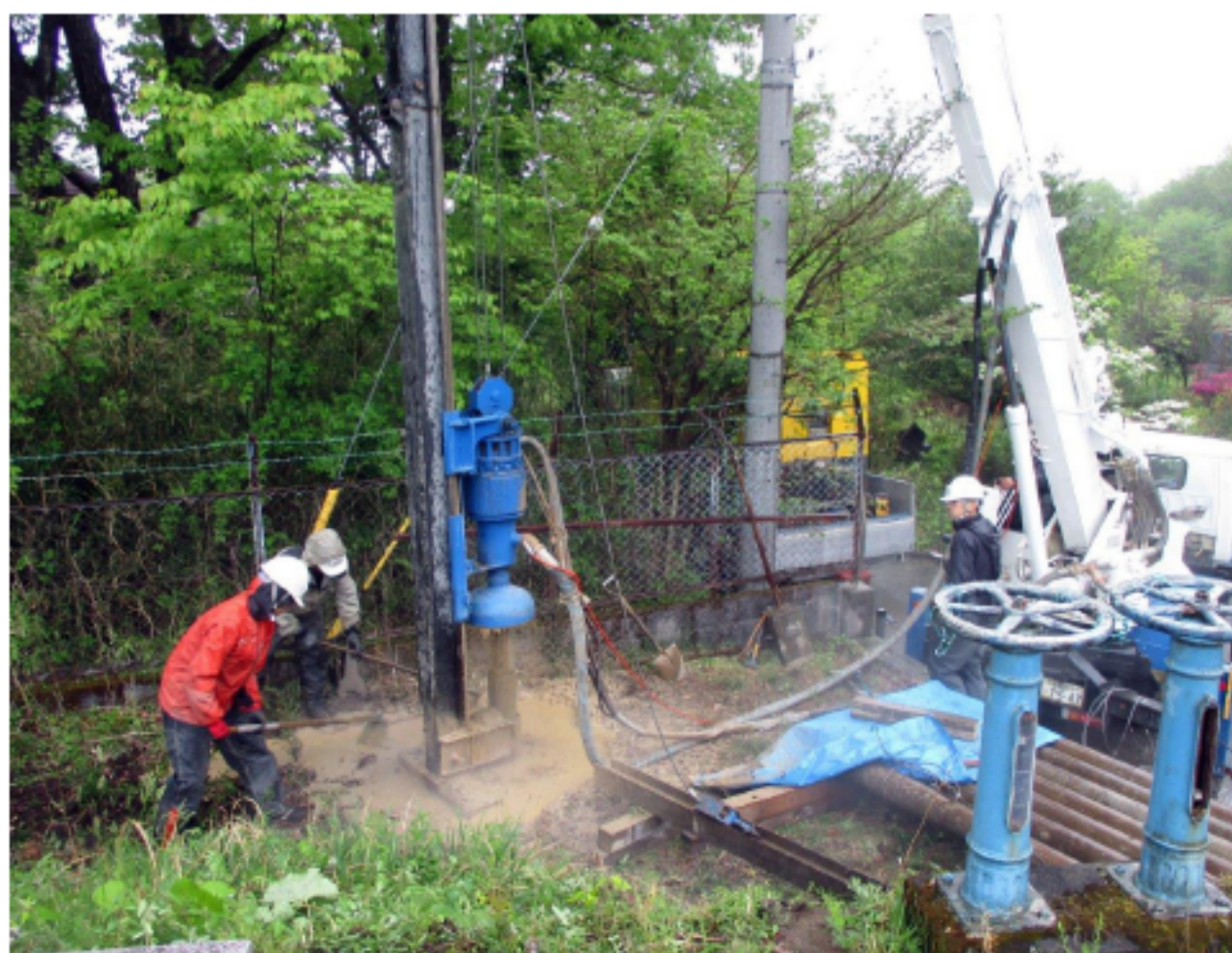
五峰苑の井戸工事。今後の濁水時の問題を回避するため、追加井戸の試掘を行いました。結果良好です
