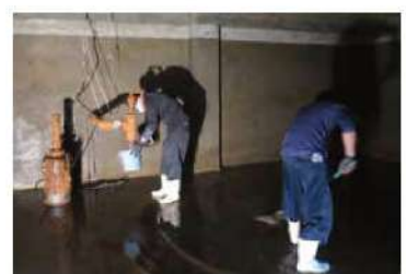
新おおとり苑の配水ポンプ交換。水道施設の維持管理は会費からの資金を投じて行っています
