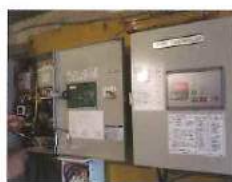
井戸・配水ポンプ制御盤交換 ●新野島苑 制御盤の不具合、接触不良の無駄なポンプ故障は出費が大きい。リスクを減らすためにも古い錆びた制御盤は交換します。
