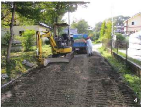
1.青木で起こった道路上の倒木は、台風によるものでした 2.神明平で行った井戸ポンプの交換 3.古くなった街灯は、ポールそのものが腐って危険な状態に。新野鳥苑での撤去作業です 4.大雨で砂利が流された白沢橋3期の道路補修
