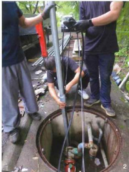
1.青木で起こった道路上の倒木は、台風によるものでした 2.神明平で行った井戸ポンプの交換 3.古くなった街灯は、ポールそのものが腐って危険な状態に。新野鳥苑での撤去作業です 4.大雨で砂利が流された白沢橋3期の道路補修
