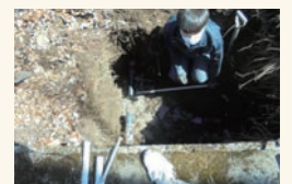
水道管の劣化により、清溪苑で行われた漏水修理です
